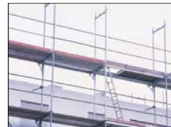
Arbeiten mit Gerüsten
